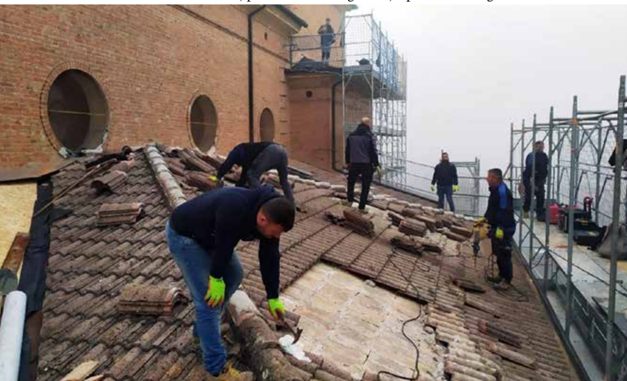
Tetto Lavori esterni, posizionamento guaina, ripasso delle tegole.
